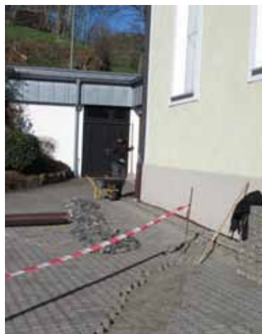
Verlegung der neuen Zuleitung
